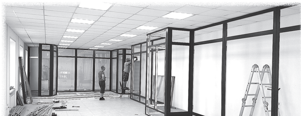
Бывшая база СМП ЮВЖД более 10 лет стояла в полуразрушенном состоянии. Теперь районные власти решили разместить в ней ряд муниципальных, областных и федеральных служб, а самое главное – краеведческий музей.
