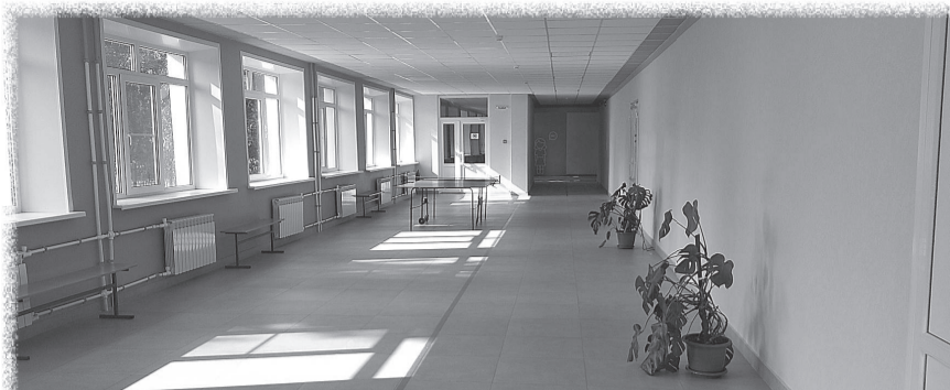
Холл СОШ №1 после капитального ремонта
